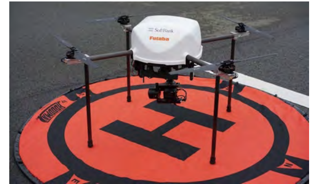
橋梁の被災状況をドローンで確認
