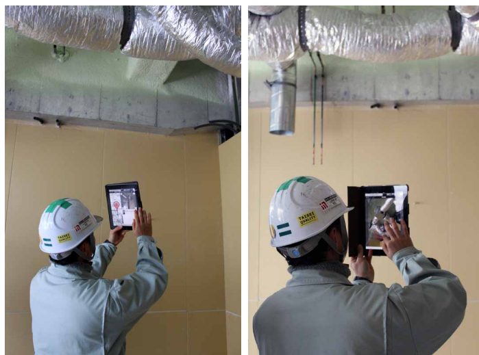
工程内検査で問題個所を見つけたら、CheXの図面上にピンを立てiPadから写真を撮影（左）。写真に手書きメモも添えられる（右）。最後にCheXのクラウド上にアップロードで情報共有は完了だ
