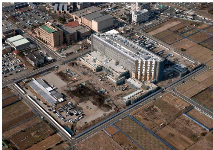
建設中の伊勢原協同病院。施主は神奈川県厚生農業協同組合連合会で、地上7階、地下1階の病院棟を中心に、緩和ケア棟、保育所棟など全3棟からなる。2014年5月末の竣工後はベッド数350床の地域中核総合病院となる
